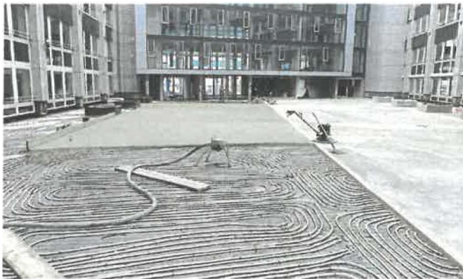
Innenfläche der Eingangshalle: Flächengröße ca. 1.400 m 2 , Fußbodenheizung. Bewegungsfugen in der Fläche werden nicht benötigt und wurden auch nicht ausgebildet. Die täglich entstandenen Arbeitsfugen sind zunächst als Pressfugen ausgebildet worden.
