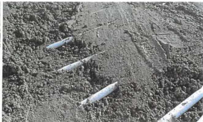
Der Estrichmörtel, hergestellt mit dem Bindemittel A58 der Ardex GmbH, ist in einer plastischen Konsistenz verarbeitet worden. In das Tragverhalten der Estrichlastverteilschicht wurden auch die Estrichbereiche zwischen den Heizrohren mit einbezogen.
