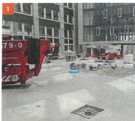
1 Damit die Fassadenflächen im inneren Bereich ausgeführt werden konnten, waren zeitweise drei Arbeitsbühnen im Einsatz. Aussparungsbereiche wurden nachträglich mit einem hochwertigen Epoxidharzestrichmörtel verfüllt.
