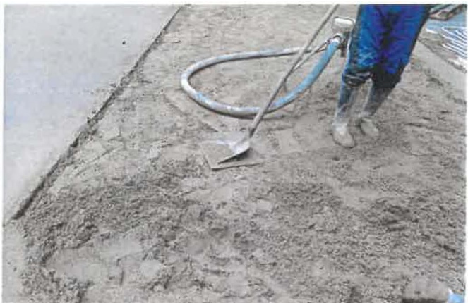
Der Estrichmörtel ist von beiden eingesetzten Estrichkolonnen zwischenverdichtet worden. Es kam entscheidend auf die hohe Qualität der Estrichverteilschicht an.
