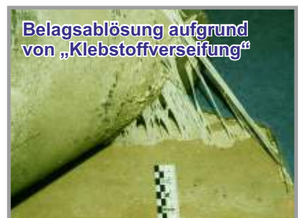
Fehlende Verbundhaftung bei Fliesen- und Platten
