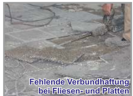
Belagsablösung aufgrund von „Klebstoffverseifung“
