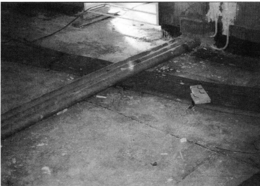
Rohrleitungen und Kabel müssen oberhalb einer Bauwerksabdichtung nach DIN 18195/4 verlegt werden.
