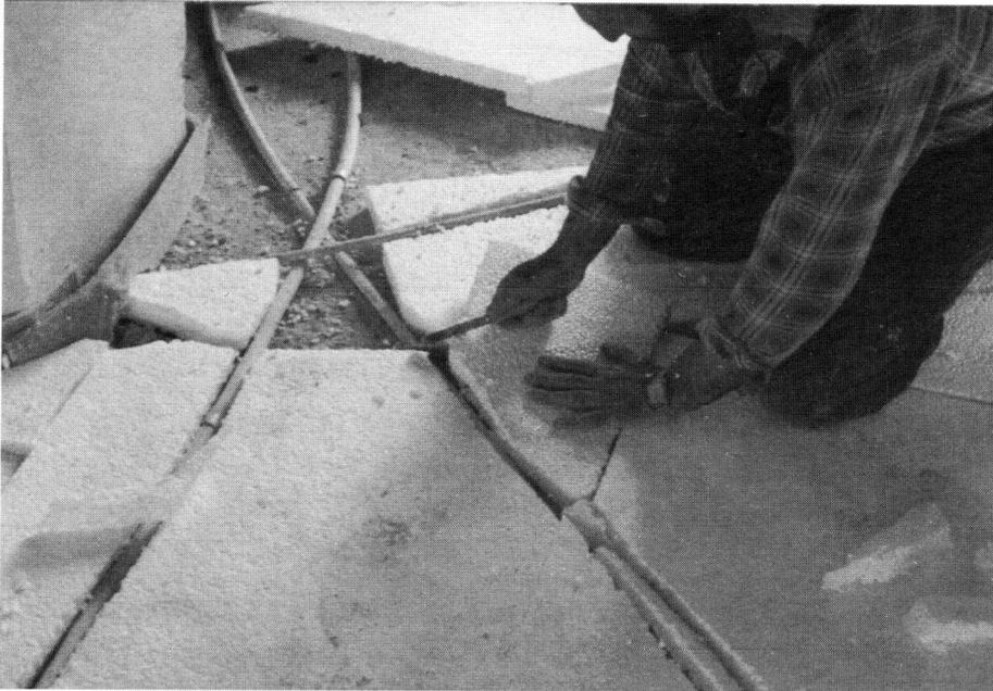
Das Herstellen einer Ausgleichsschicht aus Trittschalldämmplatten stellt keine sachgerechte Ausführung da.
