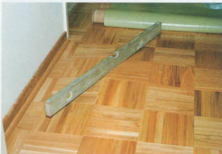
**Abb. 2: Stützt sich der Parkettboden an den Umfassungswänden aufgrund einer unnatürlichen Feuchteanreicherung ab, wird in der Regel auch der Estrich mit angehoben**
